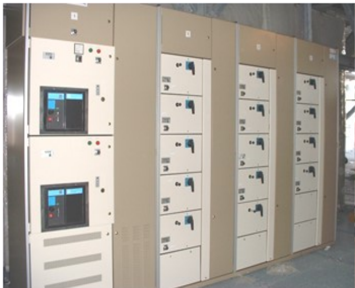
Locaux techniques distribution Basse Tension
