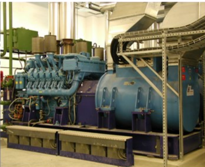
Groupes électrogènes « NO BREAK »
