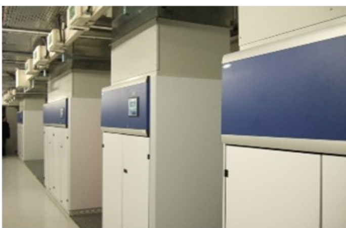
Armoires de climatisation systèmes serveurs
